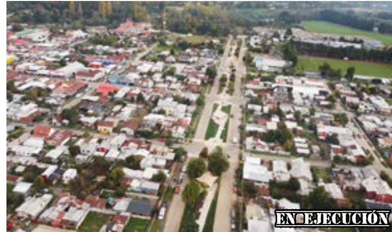
Reposición espacio público bandejón central, Avenida Colon, Mariquina.
