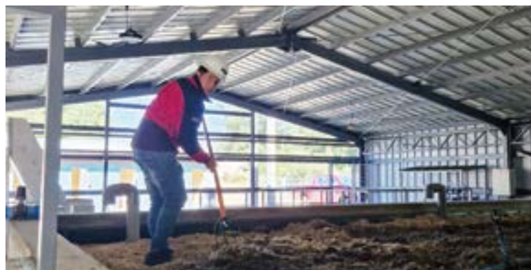
Construcción infraestructura sanitaria Estación Mariquina
