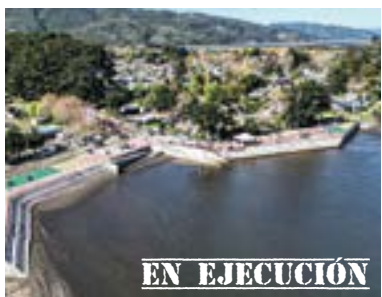
Construcción borde fluvial Río Lingue sector Mehuín comuna Mariquina
