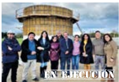
Construcción servicio de APR de Pufudi, Mariquina.
