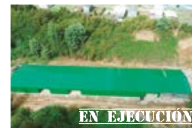
Construcción infraestructura sanitaria Estación Mariquina, Mariquina..
