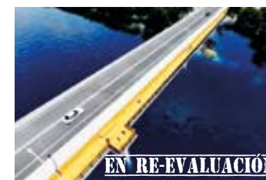
Construcción segundo acceso San José de la Mariquina.
