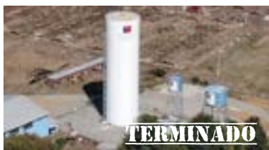
Ampliación y mejoramiento servicio APR Pelchuquin, Mariquina.
